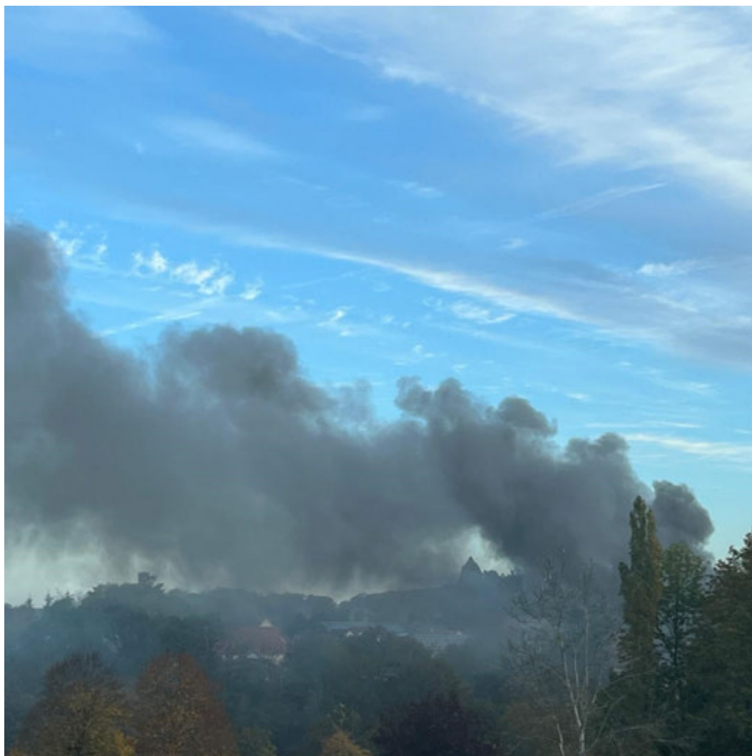
Rauchentwicklung durch einen bei Abbrucharbeiten entstanden Brand in Mäusdorf
